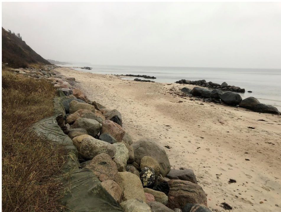
Figur 2.11 Skråningsbeskyttelse opbygget af dæksten med palisadeværk bagved ved Klintevej 65
