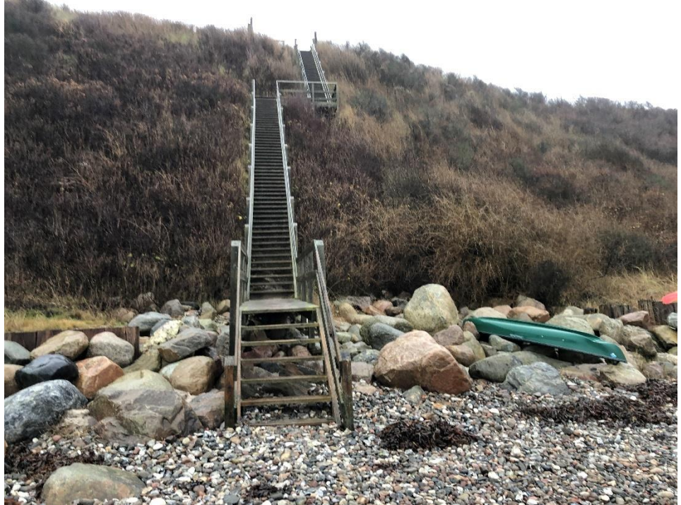
Figur 2.13 Mindre skråningsbeskyttelse ved Grundejerforeningen af 1. juni 1959 trappenedgang nordøst for Klintevej 65
