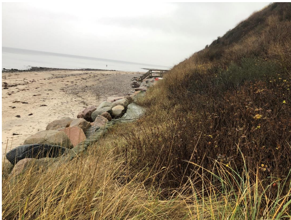
Figur 2.12 Skråningsbeskyttelse opbygget af dæksten med palisadeværk bagved ved Klintevej 65
