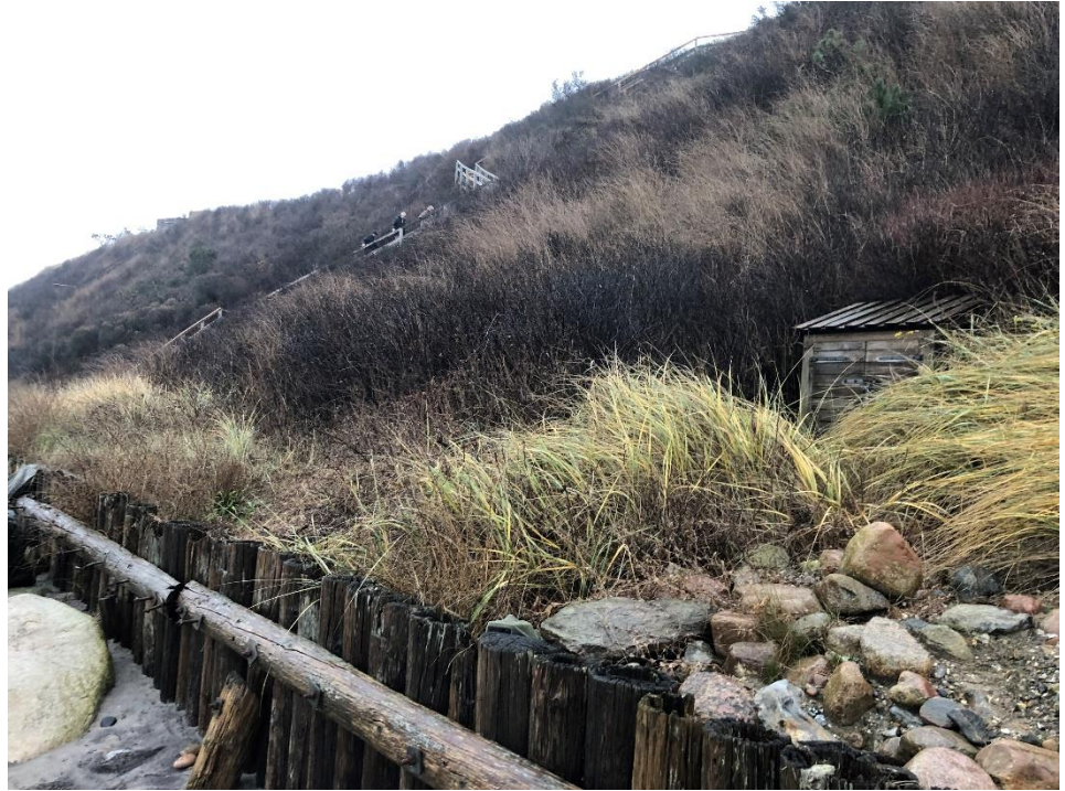
Figur 2.8 Eksisterende palisadeværk ud for Klintevej 61
