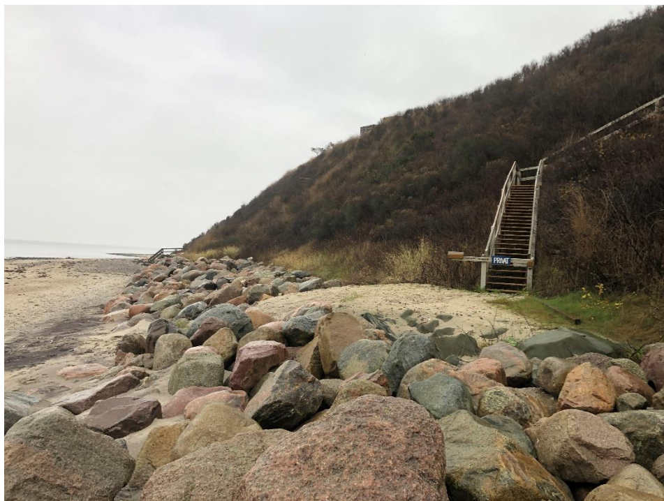
Figur 2.10 Skråningsbeskyttelse nedenfor Klintevej 63
