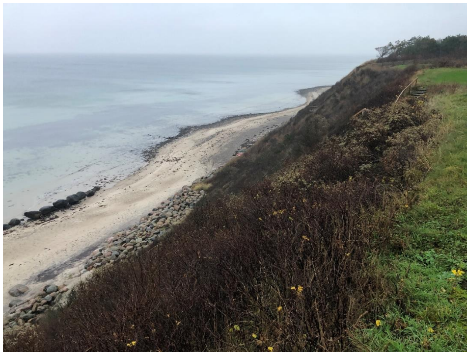
Figur 2.7 Bevokset skrånning ud for Klintevej 61 (forgrunden) og 63 (baggrunden)
